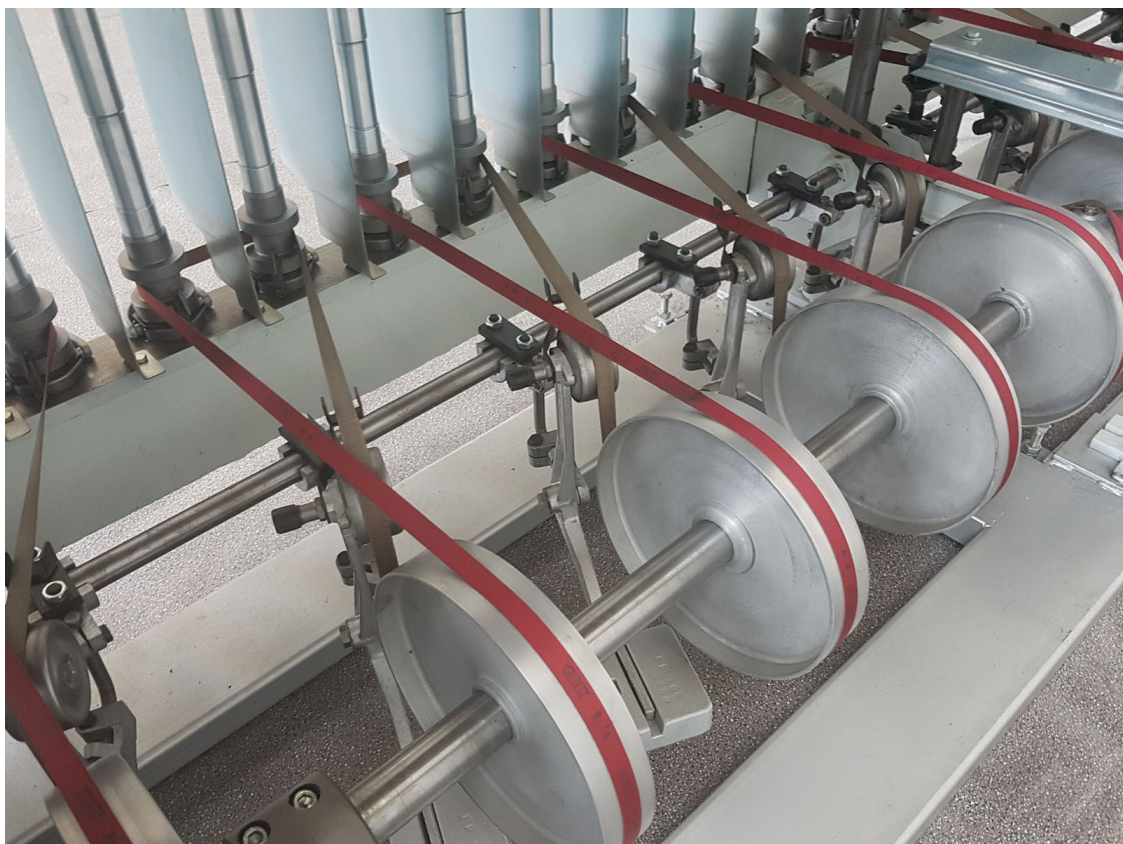
Figura 4.4.2 – Verifica di cinghie, pulegge e tenditori
