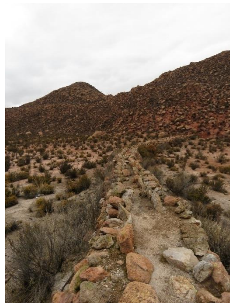
Figura 61. Acueducto de Tablatablane sobre el tramo C (Pachama-Belén vía Tongolaca)
