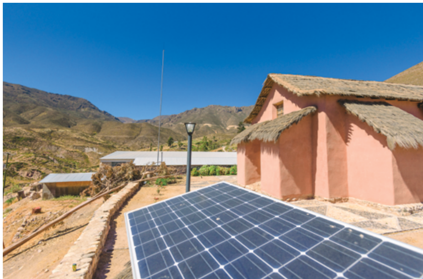
IGLESIA DE SOCOROMA: SE CONSTRUYÓ A MEDIADOS DEL SIGLO XVI Y SE RESTAURÓ EN 2013. UN PANEL FOTOVOLTAICO, UBICADO EN UNA ESQUINA DEL RECINTO, LA ABASTECE DE ELECTRICIDAD.
