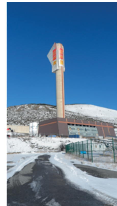
LA CENTRAL SOLAR THEMIS OPERÓ DE 1983 A 1986. LA PRIMERA CON ACUMULACIÓN TÉRMICA EN SALES FUNDIDAS.
