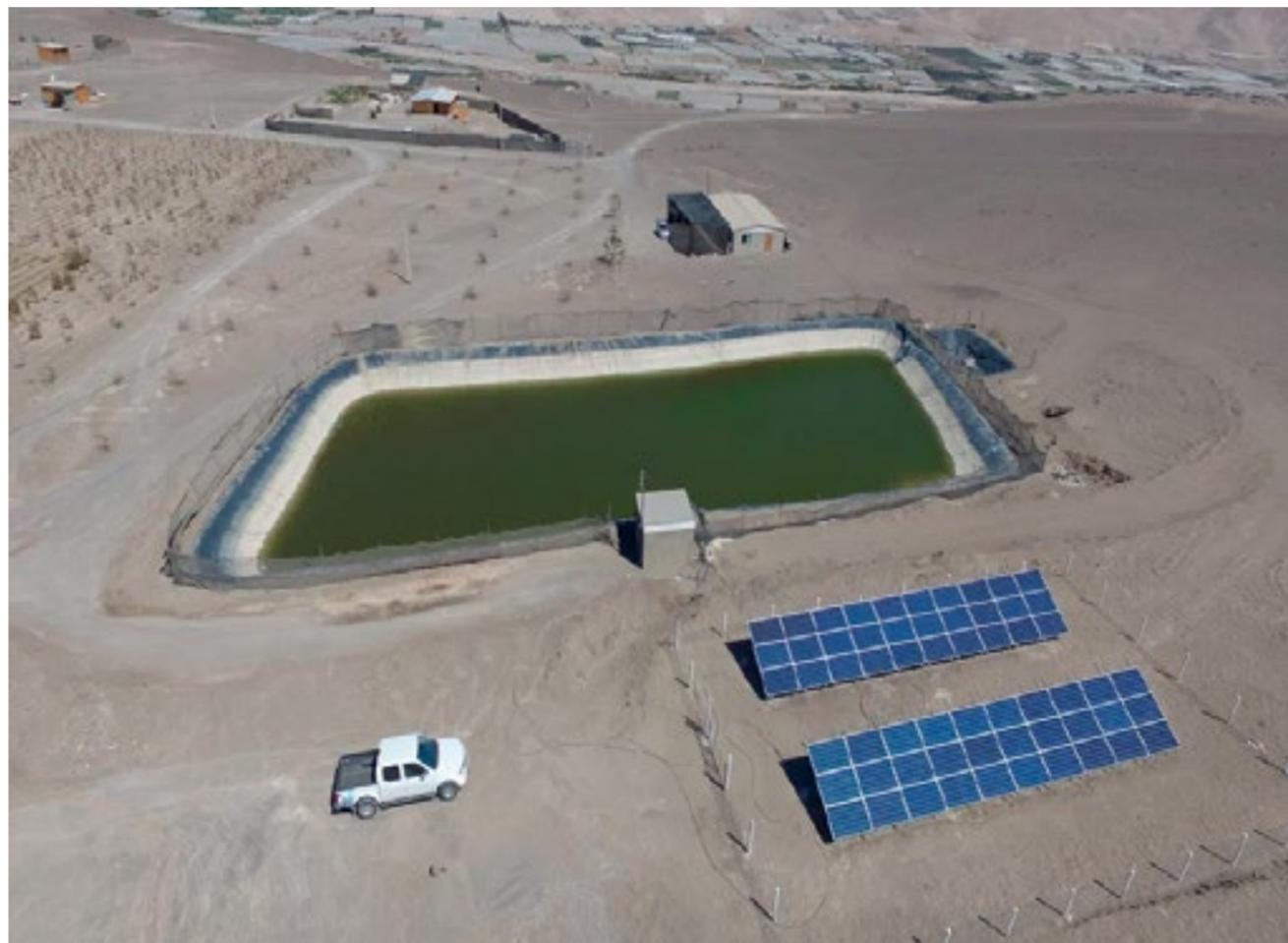
SISTEMA DE BOMBEO SOLAR LOS LAGOS: 60 PANELES Y 15 KW DE POTENCIA ENTREGAN ENERGÍA PARA REGAR 36 HECTÁREAS DE TERRENO CULTIVABLE EN LOS CERROS DEL VALLE DE AZAPA.
